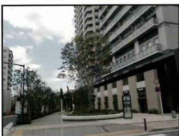
駅側のオープンスペースは、安全に歩行できる広い歩道上空地となっています。
